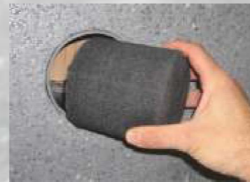
Diffusionszylinder aus hochwertigem, diffusionsoffenem, wärmedämmendem Schaumstoff
