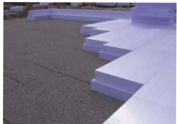
Die extrem druckstabilen Platten nehmen ein Gewicht bis zu 700 kPa auf und sind dennoch hoch wärmedämmend.
