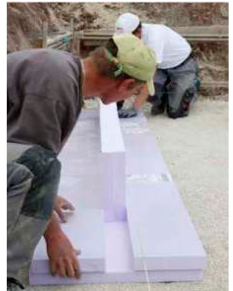
Die Schalungselemente werden in die Seitenteile gesteckt. Die Nuten gewährleisten absolute Wärmebrückenfreiheit.
