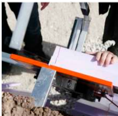
Die MAGU Atlaselemente werden mit einer Glühdrahtschneidemaschine auf Maß geschnitten. mühelos lassen sich damit Stufenfalze realisieren.
