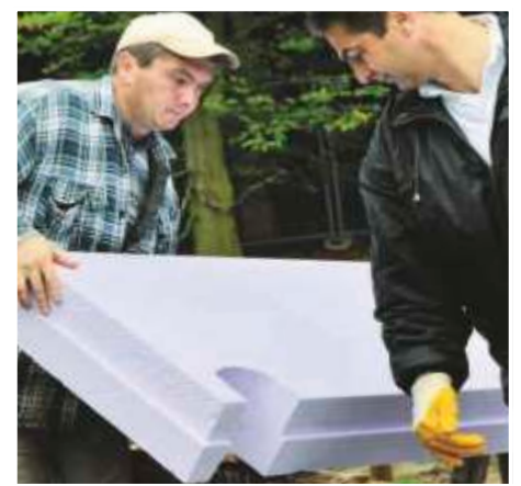
Aussparungen in der Wärmedämmschicht, z.B. durch Entwässerungsleitungen, lassen sich mit einer Tiger- oder Motorsäge ausschneiden.
