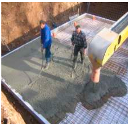
Schließlich wird die Platte betoniert und ausreichend verdichtet und eben abgezogen.
