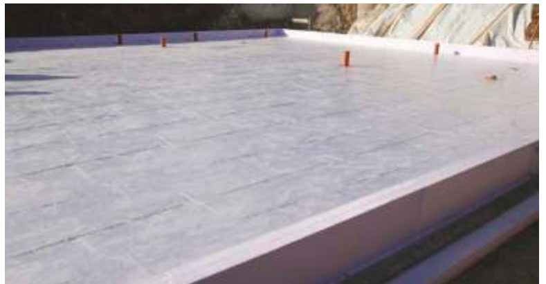
Nach kurzer Zeit ist das MAGU Atlas Wärmedämm- und Schalungssystem verlegt. Durch das Stecksystem entfällt das Ausschalen der Bodenplatte. Eine zusätzliche Sicherung vor dem Betonieren ist nicht erforderlich.
