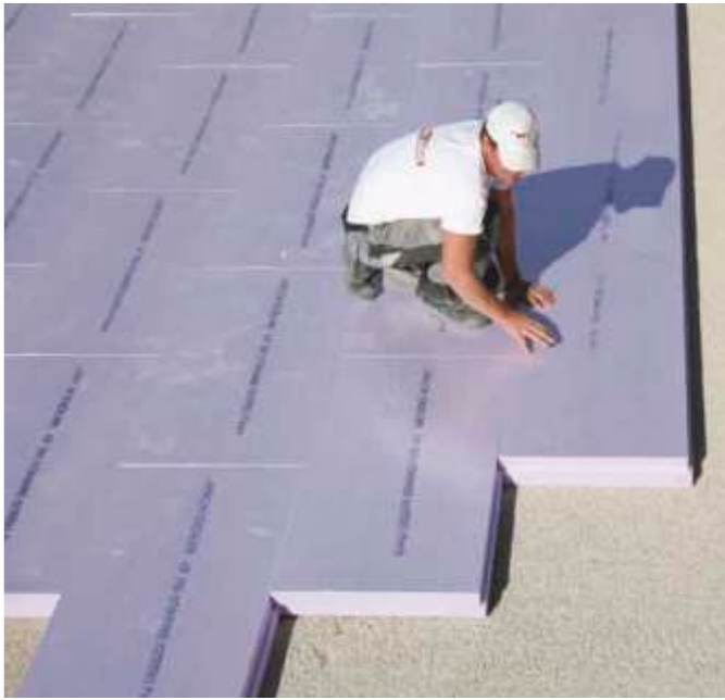
Um Kreuzfugen zu Vermeiden erfolgt die Verlegung der MAGU Atlas Flächenelemente im Verband.
