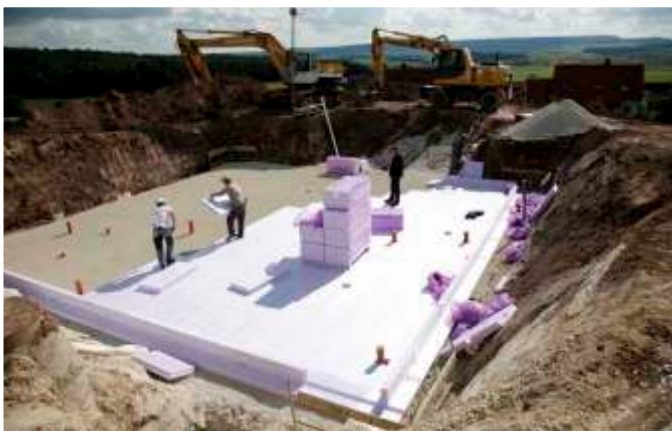
Die lastabtragende Bodenplatte ist in wenigen Stunden verlegt - kein zusätzliches Ein- und späteres Ausschalen.
